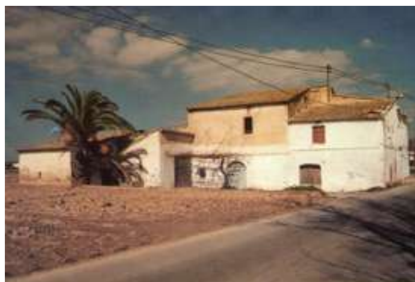
Figure 65. Alqueria del Roig del Cristo. Pouet de Campanar Fotografía de Antonio Falcó
