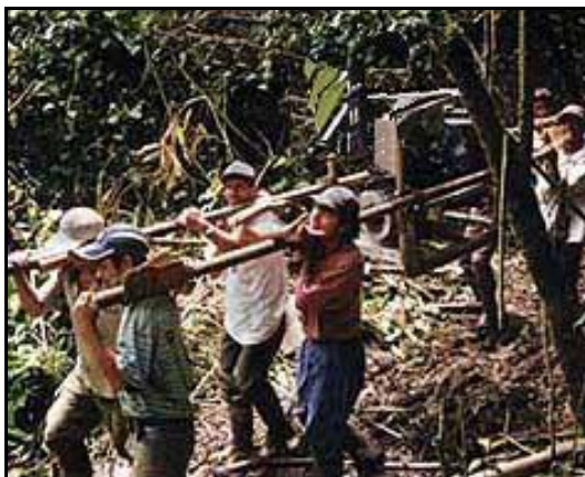
Figura II.5 Forma de transportación de los equipos móviles de barrenación
